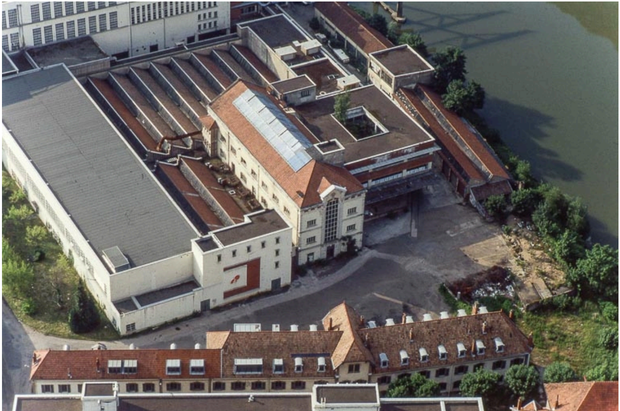
Vue aérienne de l'usine A depuis le nord-ouest : atelier de fabrication (S), cantine et bureaux.
