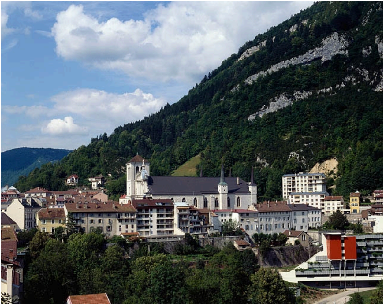
Vue générale de l'église depuis le cimetière.
