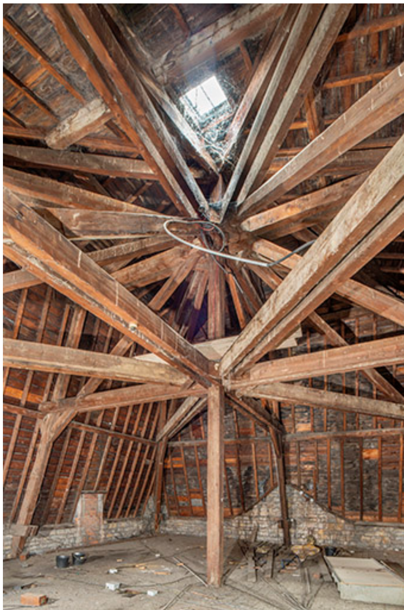
Charpente du pavillon ouest.
