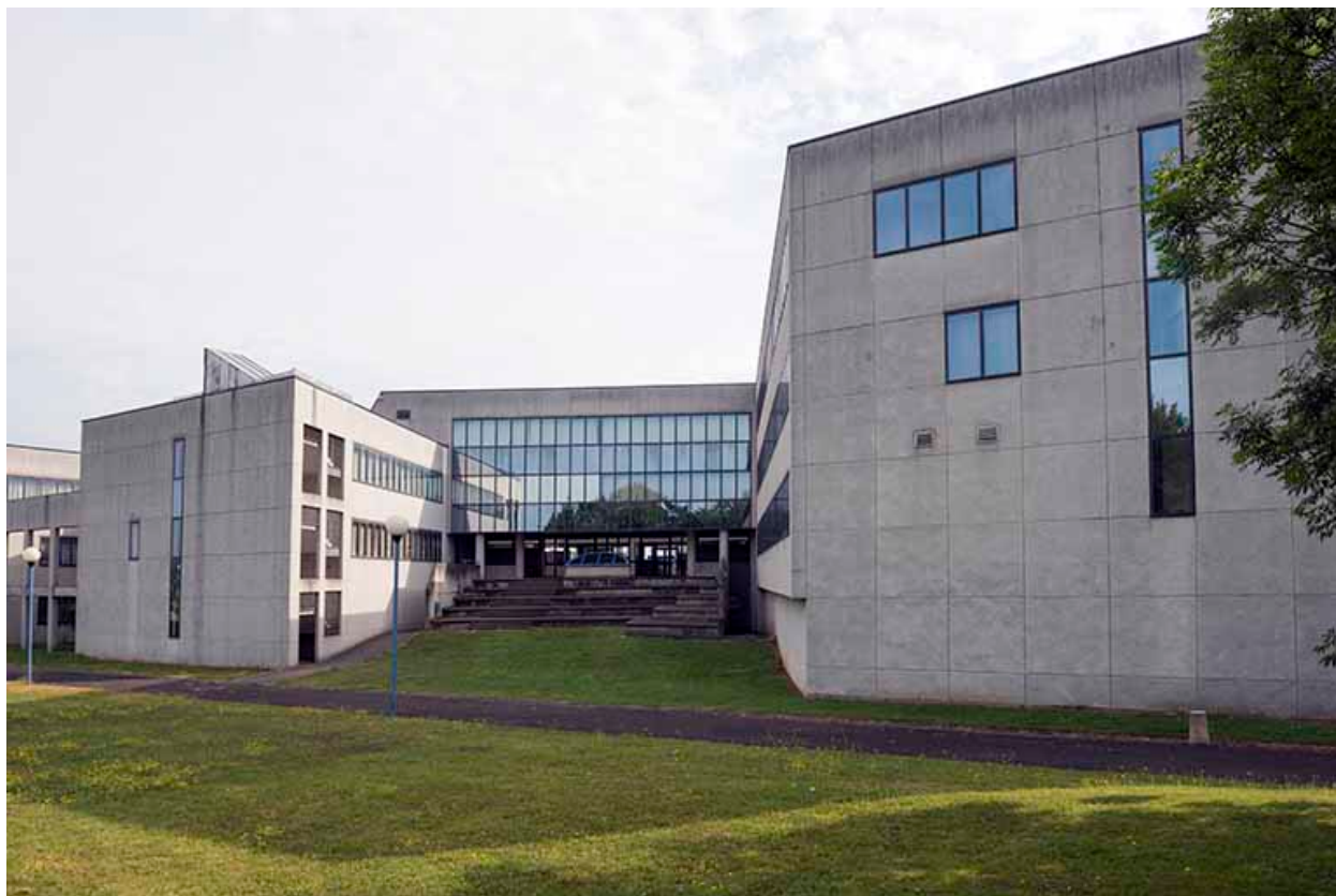
Détail d'un préau de la façade sud.
