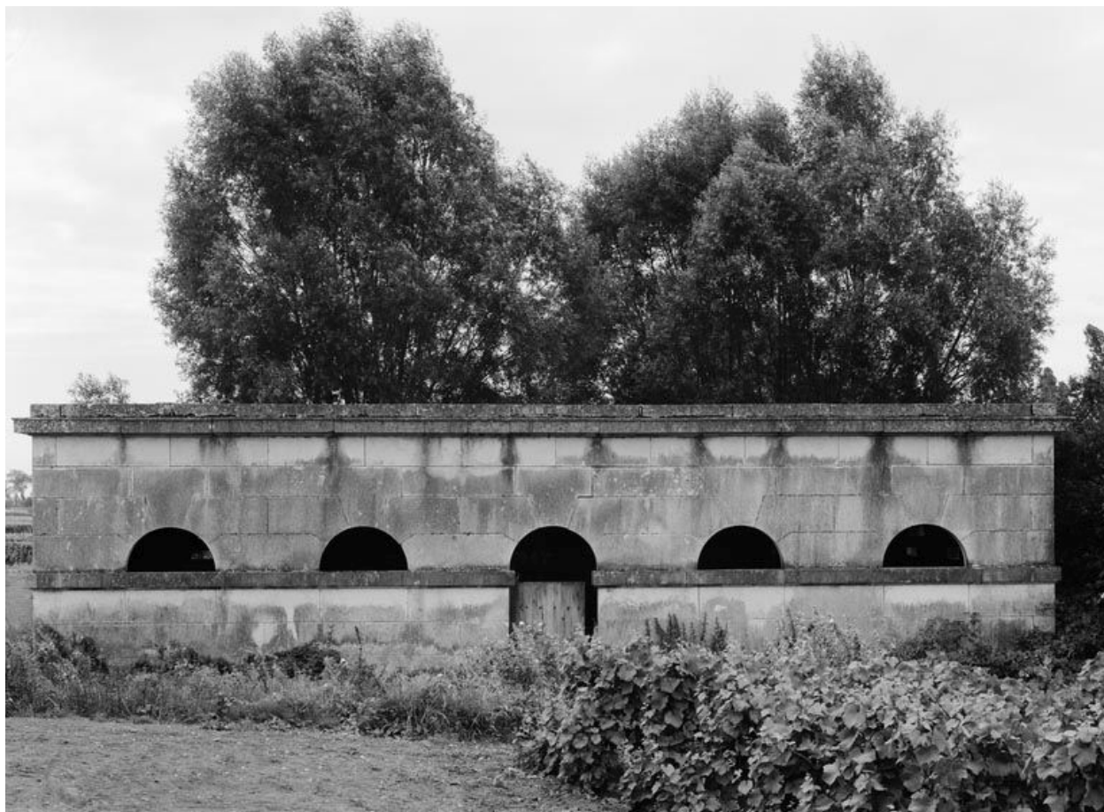
Vue de la façade antérieure du lavoir.
