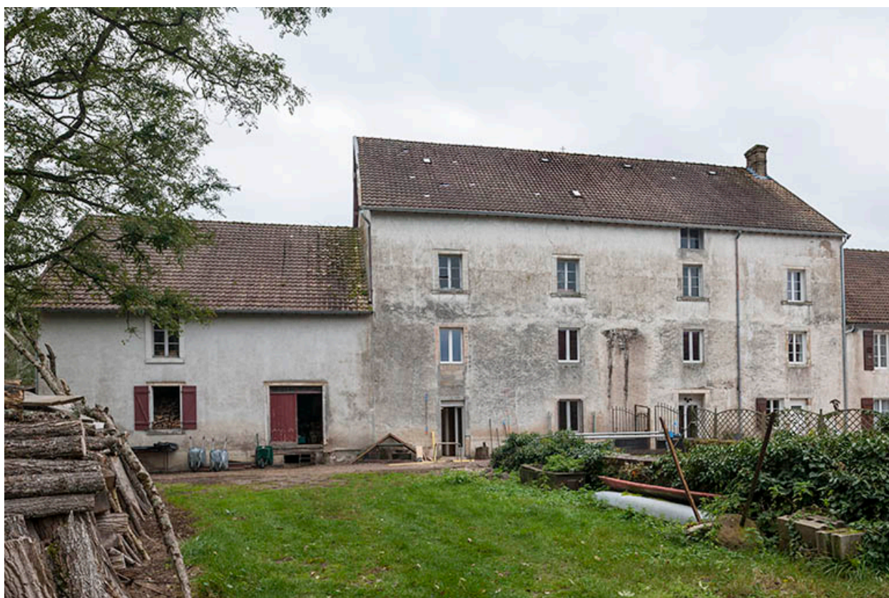
Façade ouest de l'atelier de minoterie.
