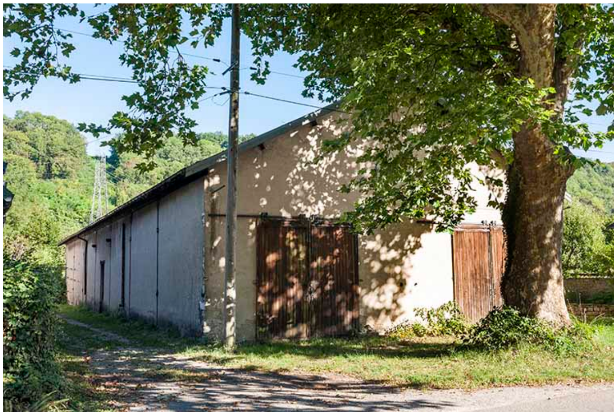
Magasin industriel vu depuis la route.
