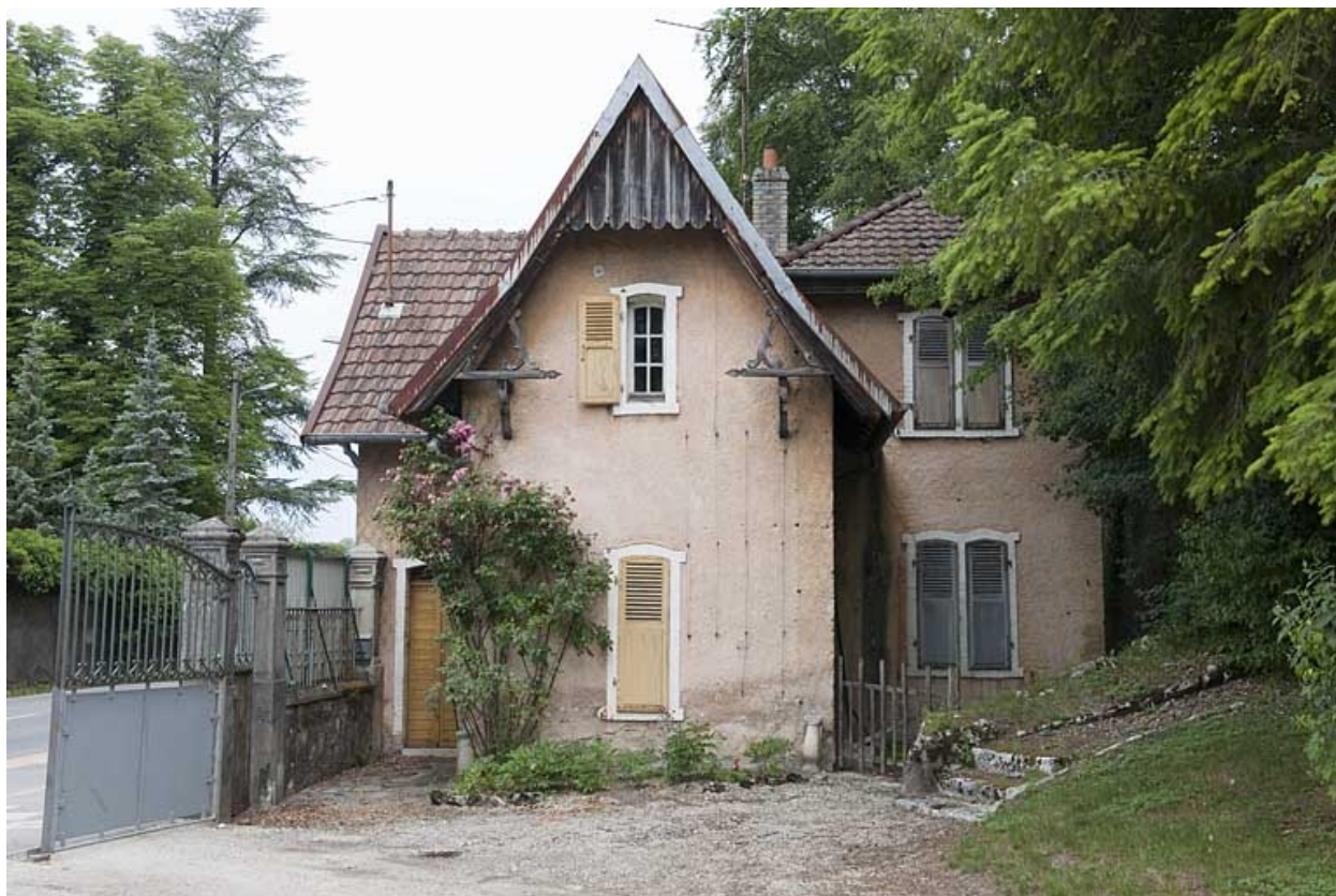
Façade sud de la conciergerie.
