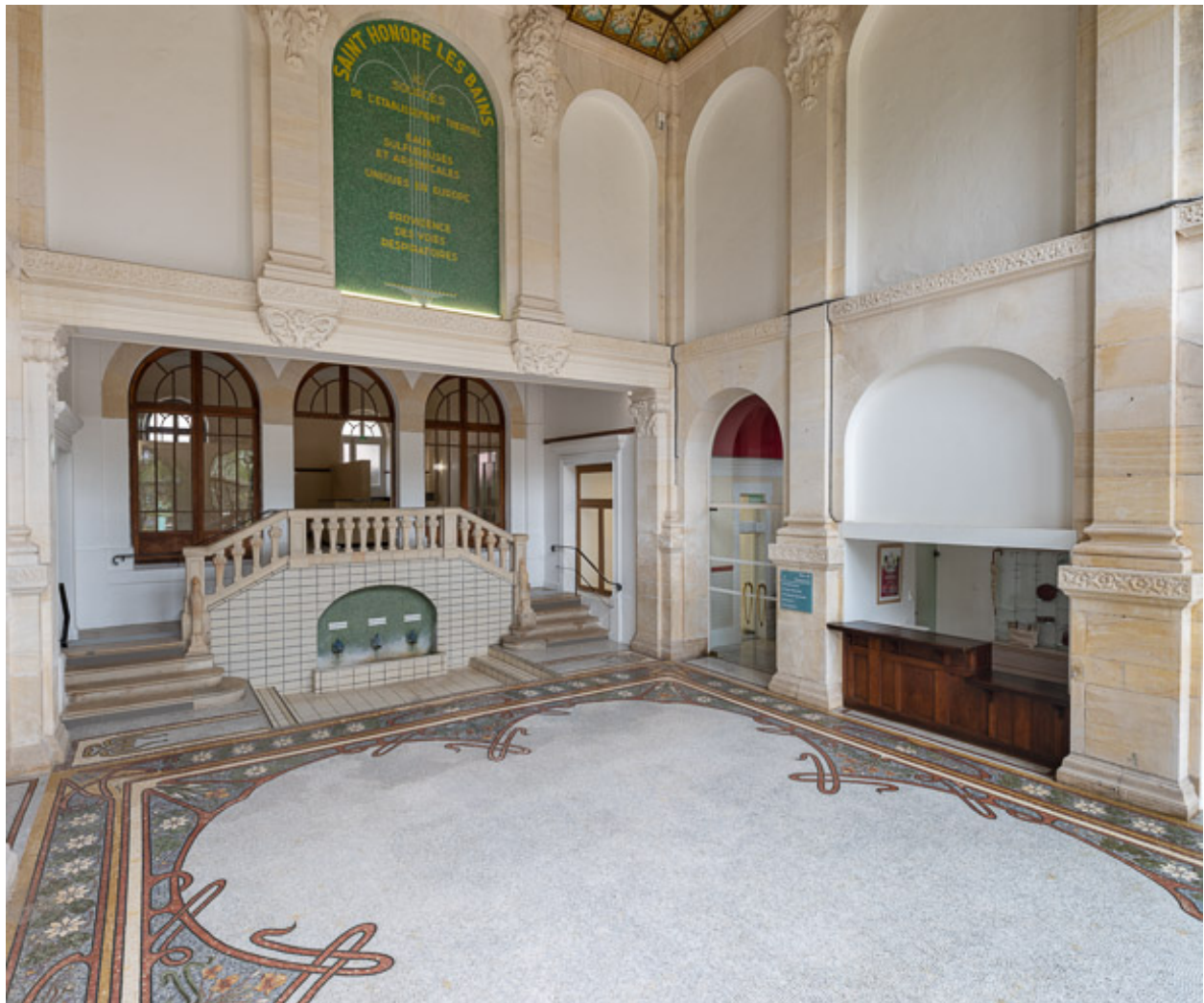
Hall des sources, vue d'ensemble vers le sud-est.
