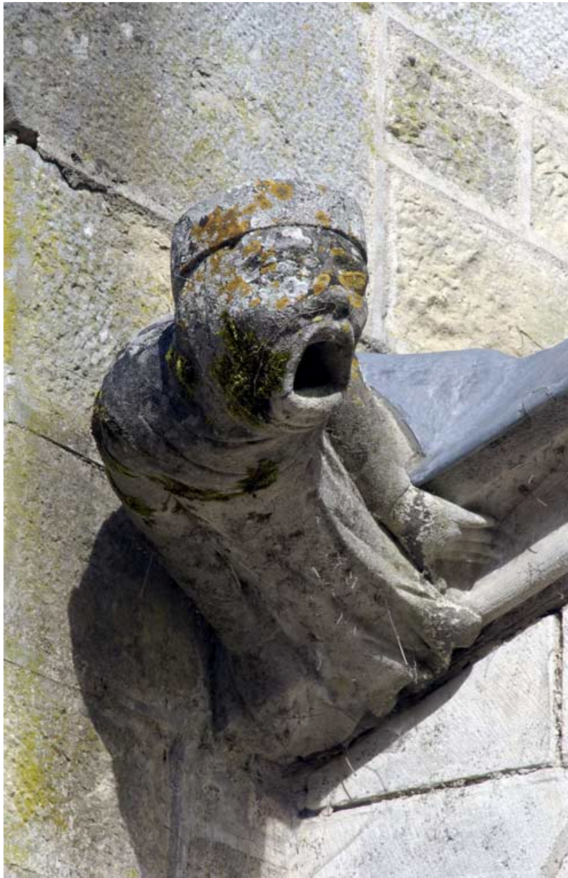
Bâtiment du réfectoire : élévation ouest, gargouille néo-gothique.
