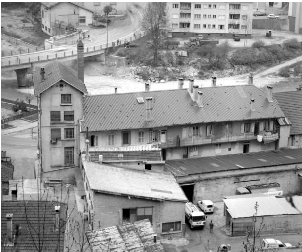
Vue d'ensemble plongeante depuis l'est.
