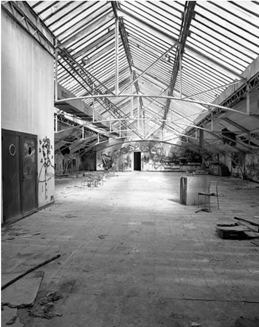
Charpente métallique et verrière de la cantine (cadrage vertical).
