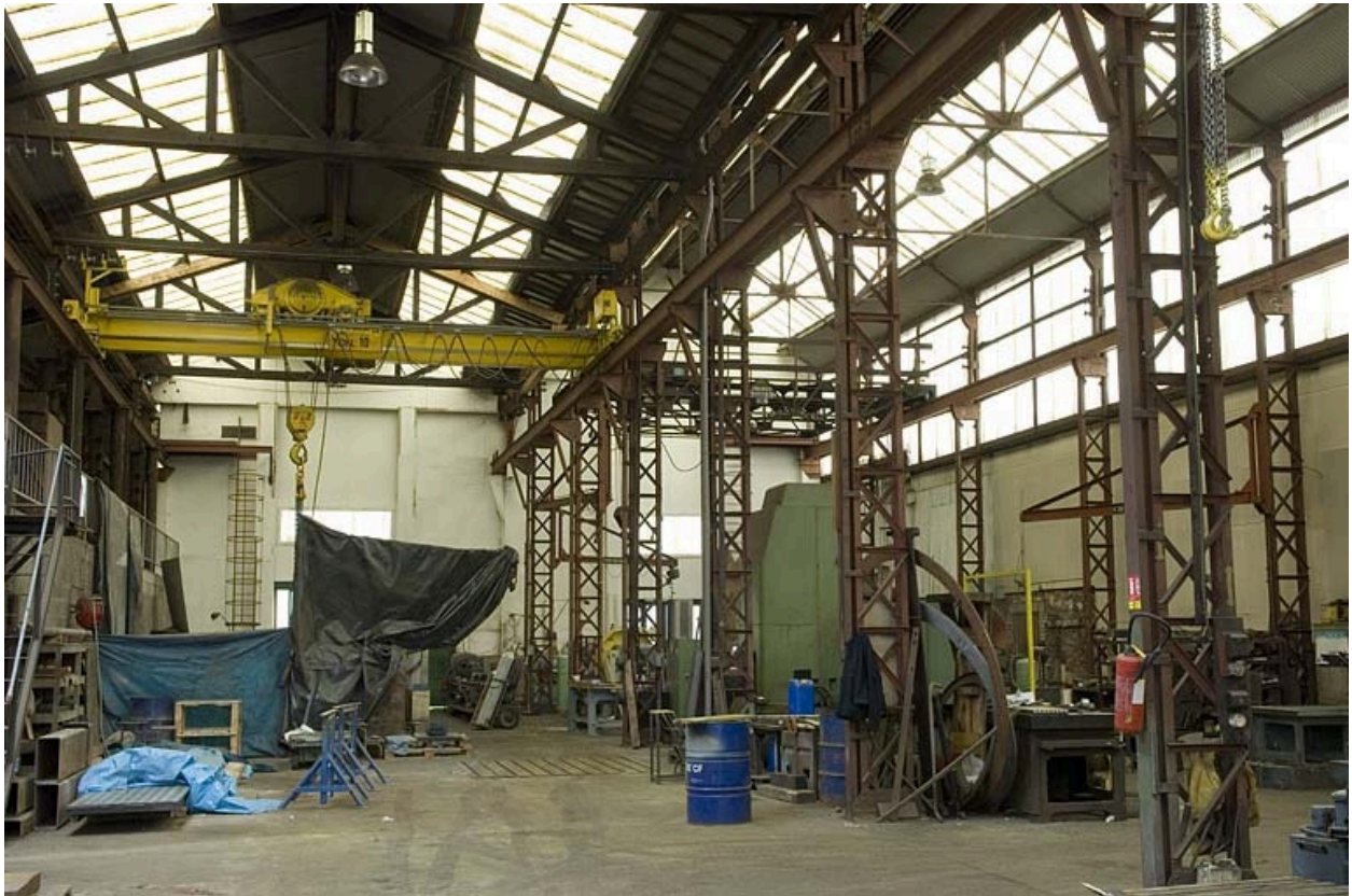
Atelier de mécanique. Structure et charpente métallique.
