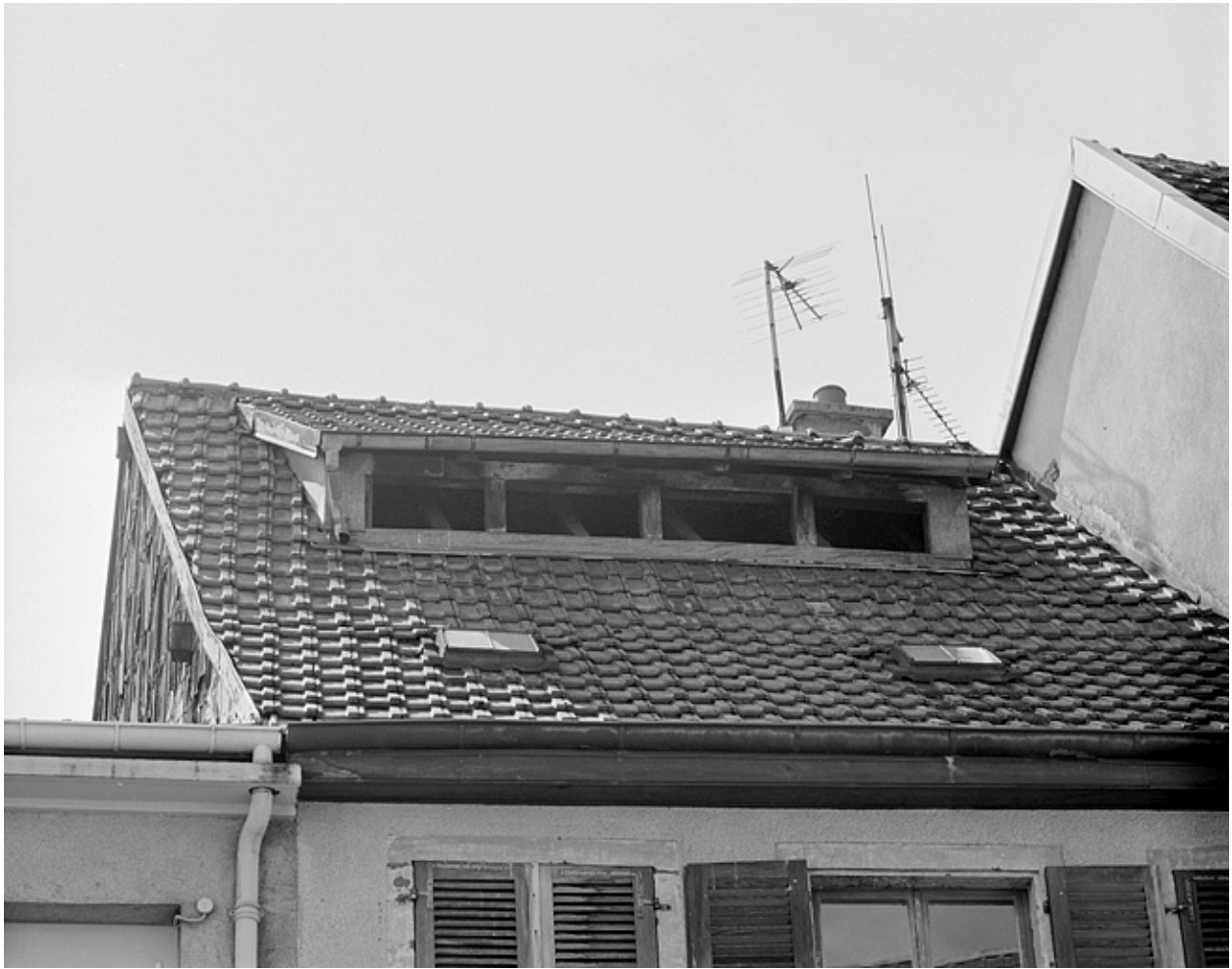
Maison 32, rue des Febvres. Première moitié 19e siècle.
