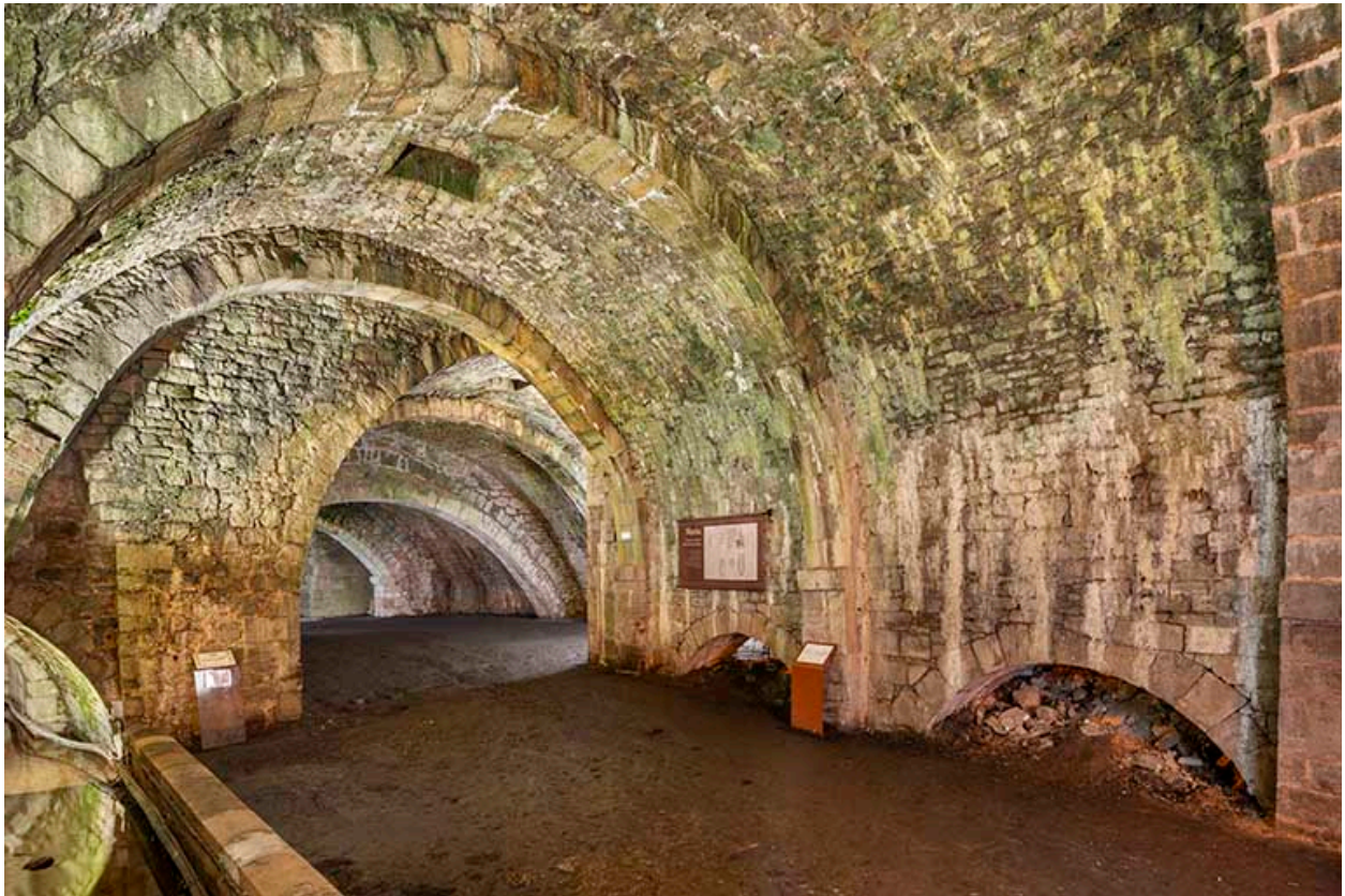
Puits d'Aval (ou à Grès). Vue depuis le sud.
