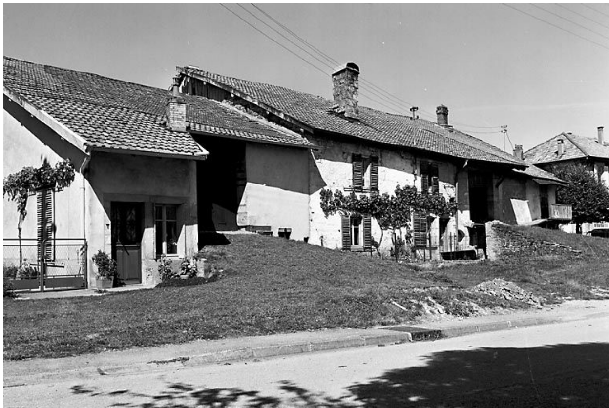
Façade antérieure vue de trois quarts gauche.
