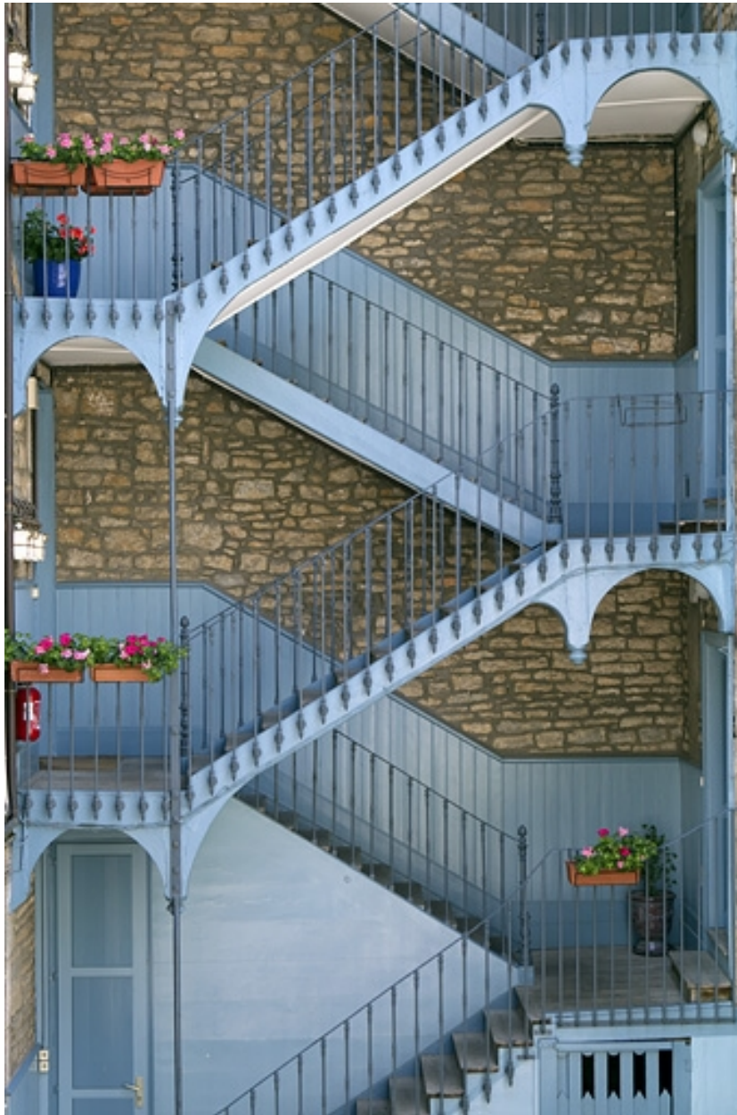
Détail de l'escalier à cage ouverte à gauche de la cour.
