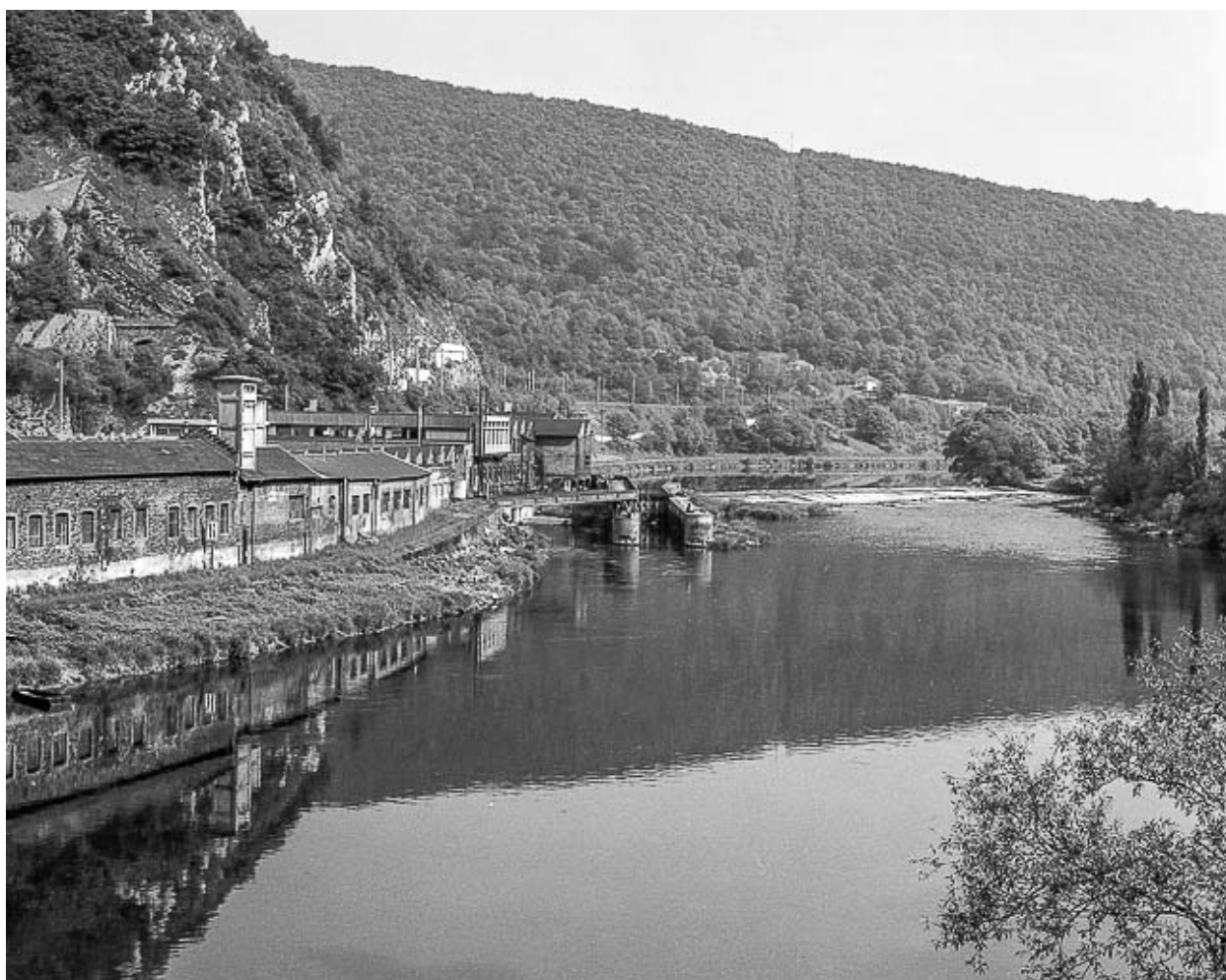
Vue d'ensemble depuis le pont en 1976.
