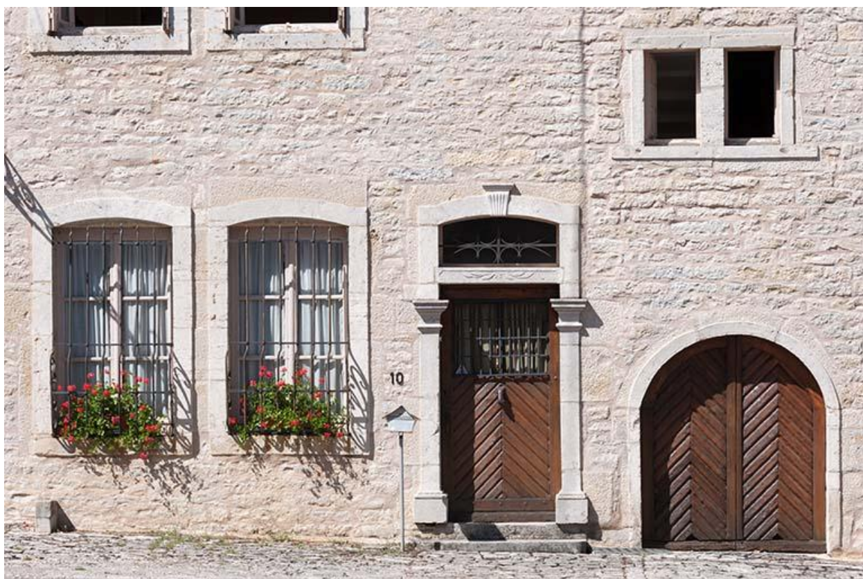
Détail des baies de la façade sud
