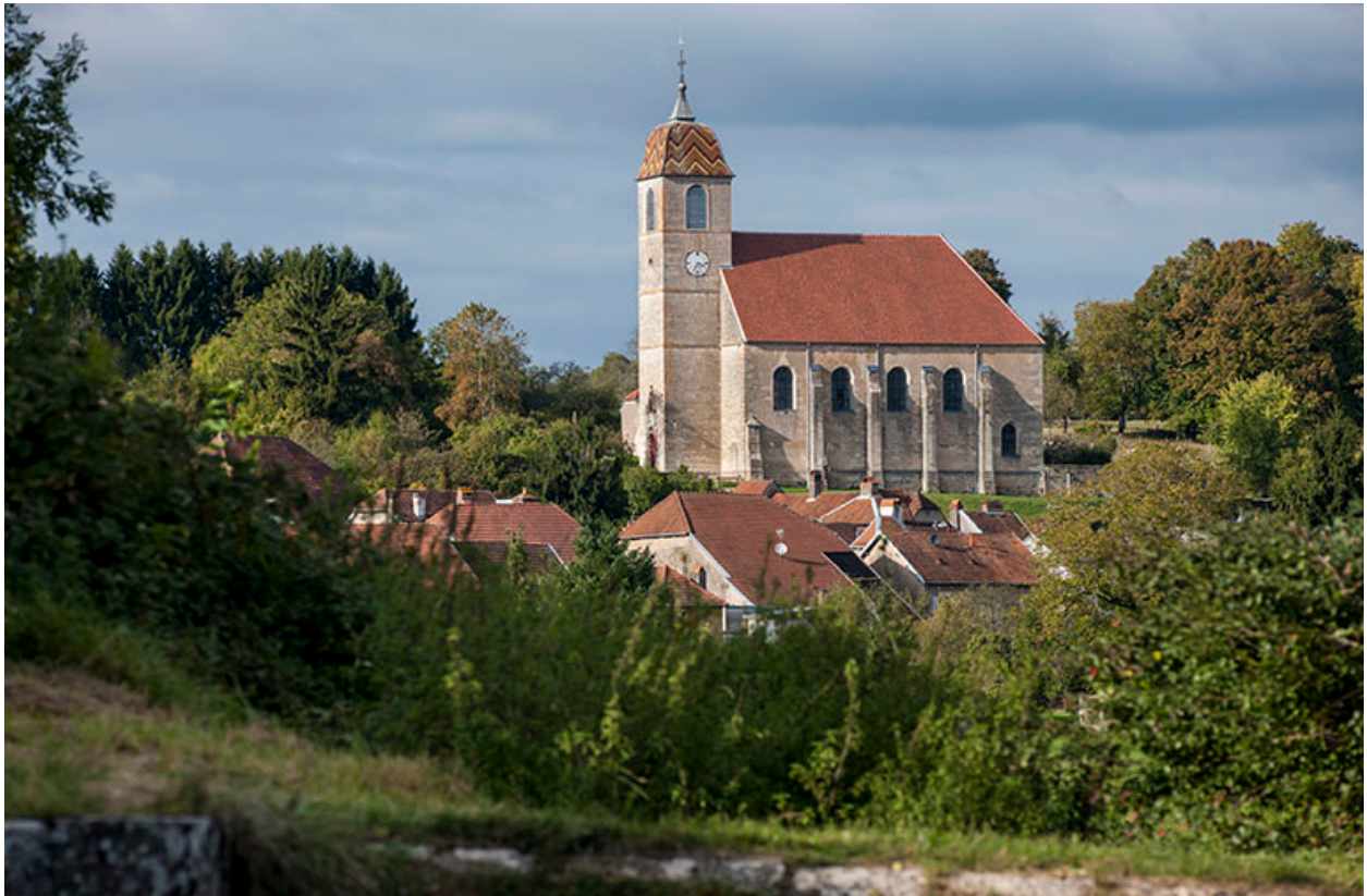
Vue générale depuis la Saône.
