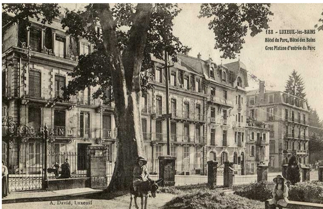
Rue des Thermes, façades de l'Hôtel du Parc et de l'Hôtel des Bains.
