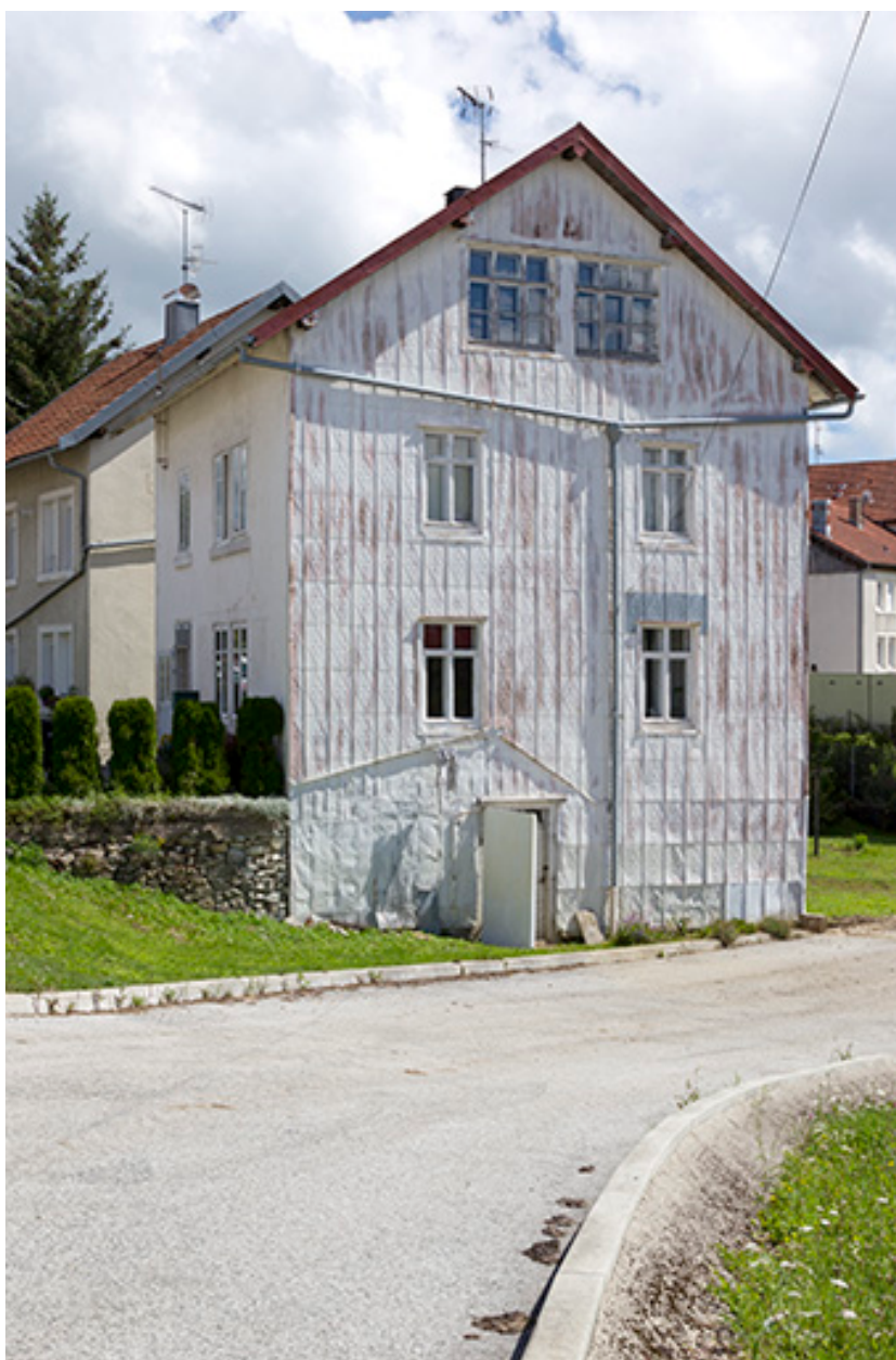
Façade latérale droite, de trois quarts gauche.
