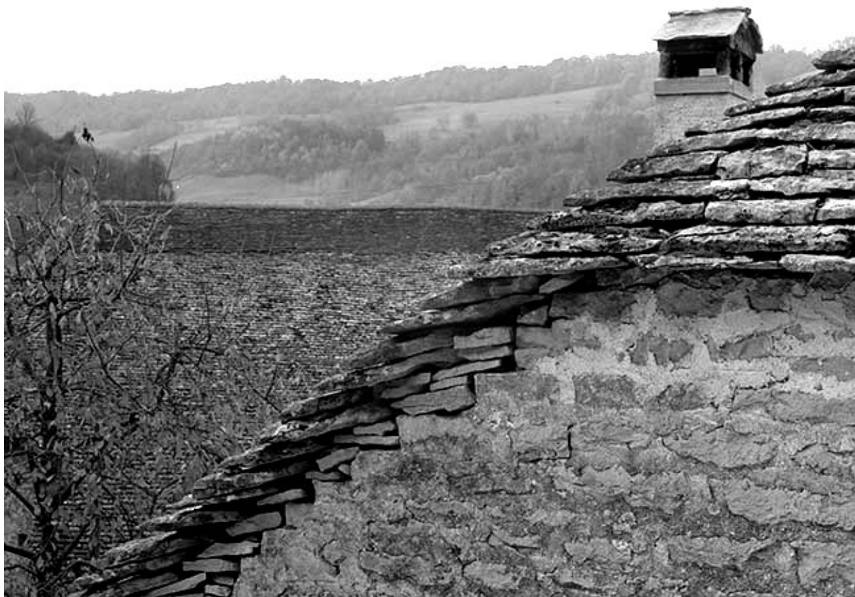
Détail d'une bordure de toit en laves.
