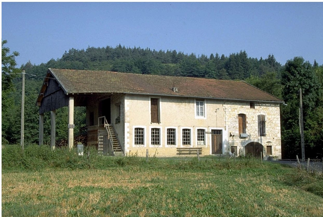
Usine de tableterie dite tournerie communale, Valfin-sur-Valouse (la Tournerie).
