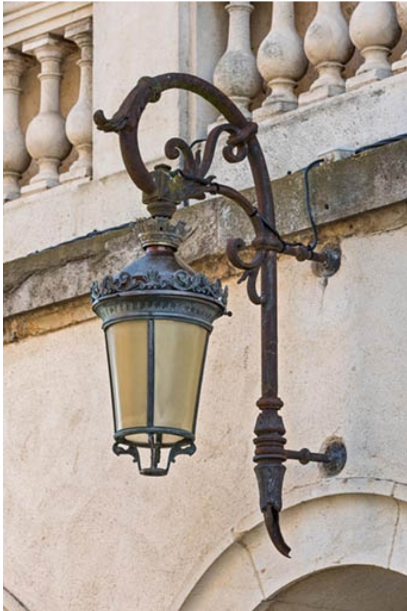
Façade antérieure : une lanterne.
