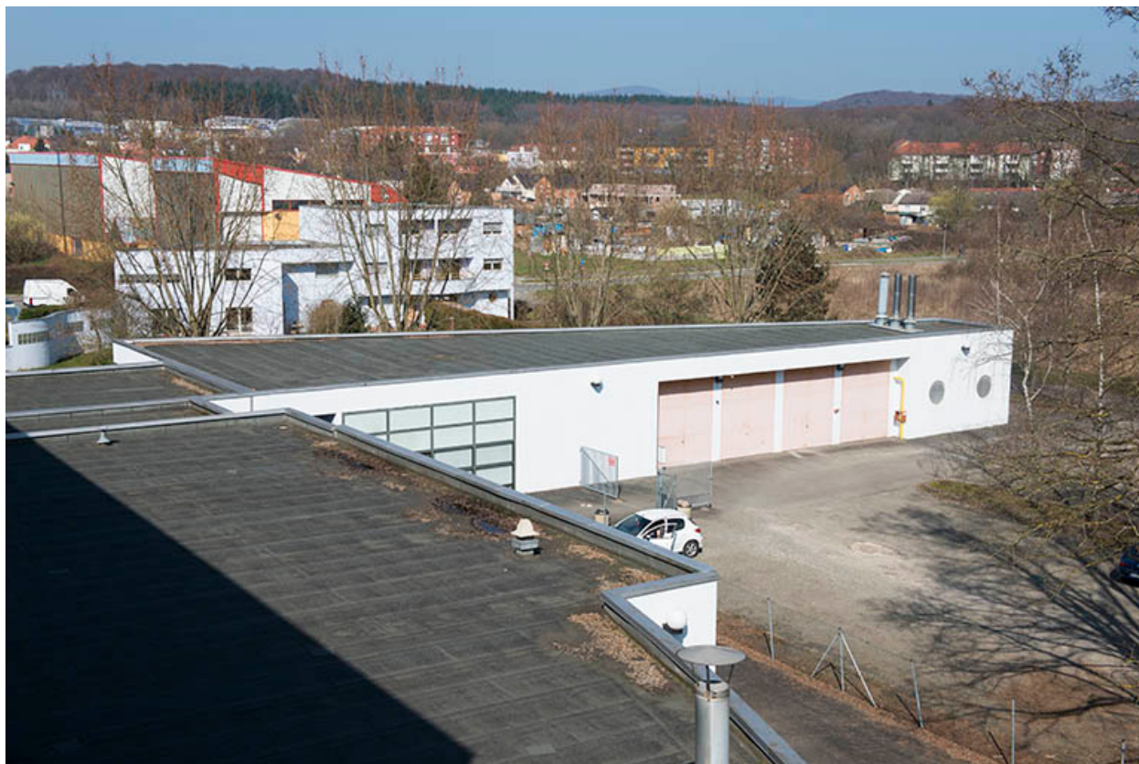
Façade sud des réserves.
