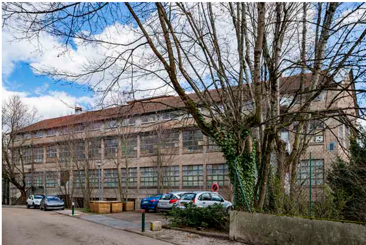
Façade ouest de l'entrepôt industriel.
