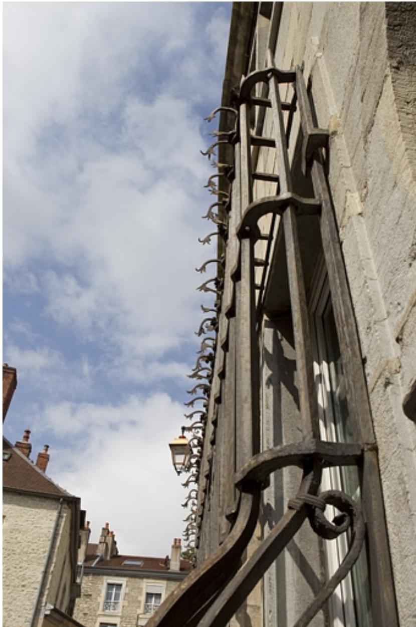
Façade sur rue du logis principal : détail des grilles devant les fenêtres du rez-de-chaussée, de profil, vue rapprochée.
