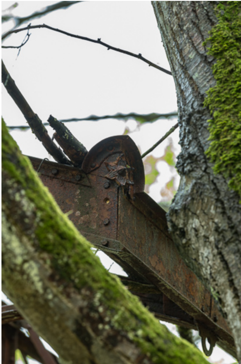
Vestiges des promenoirs d'Ernest Panz remontés sur le site de Pougues-Bellevue.
