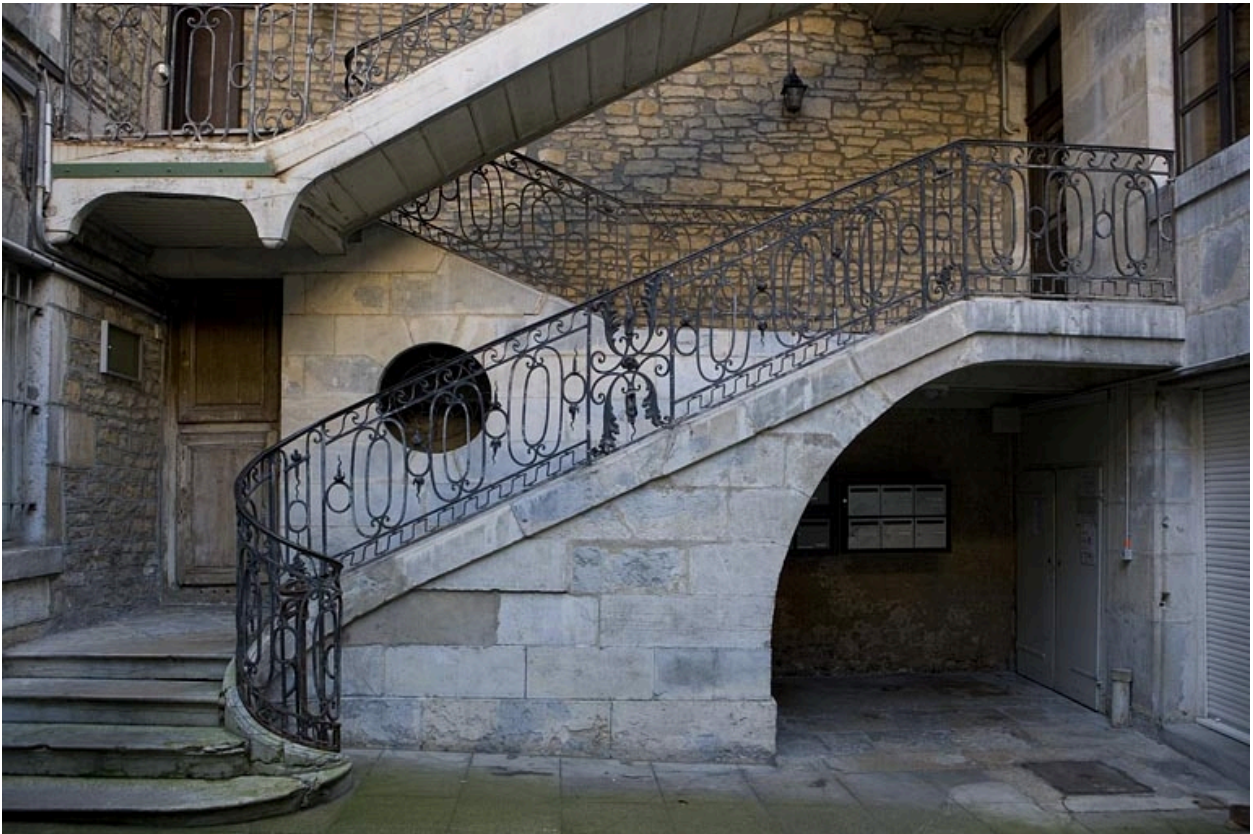
Détail de la première volée de l'escalier à cage ouverte depuis la cour.
