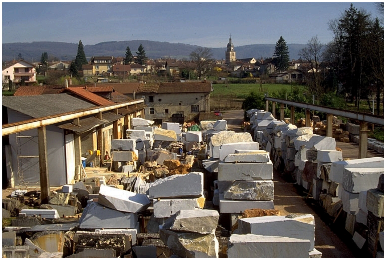
Usine de taille de matériaux de construction Carron, à Saint-Amour : ateliers et aire des matières premières.
