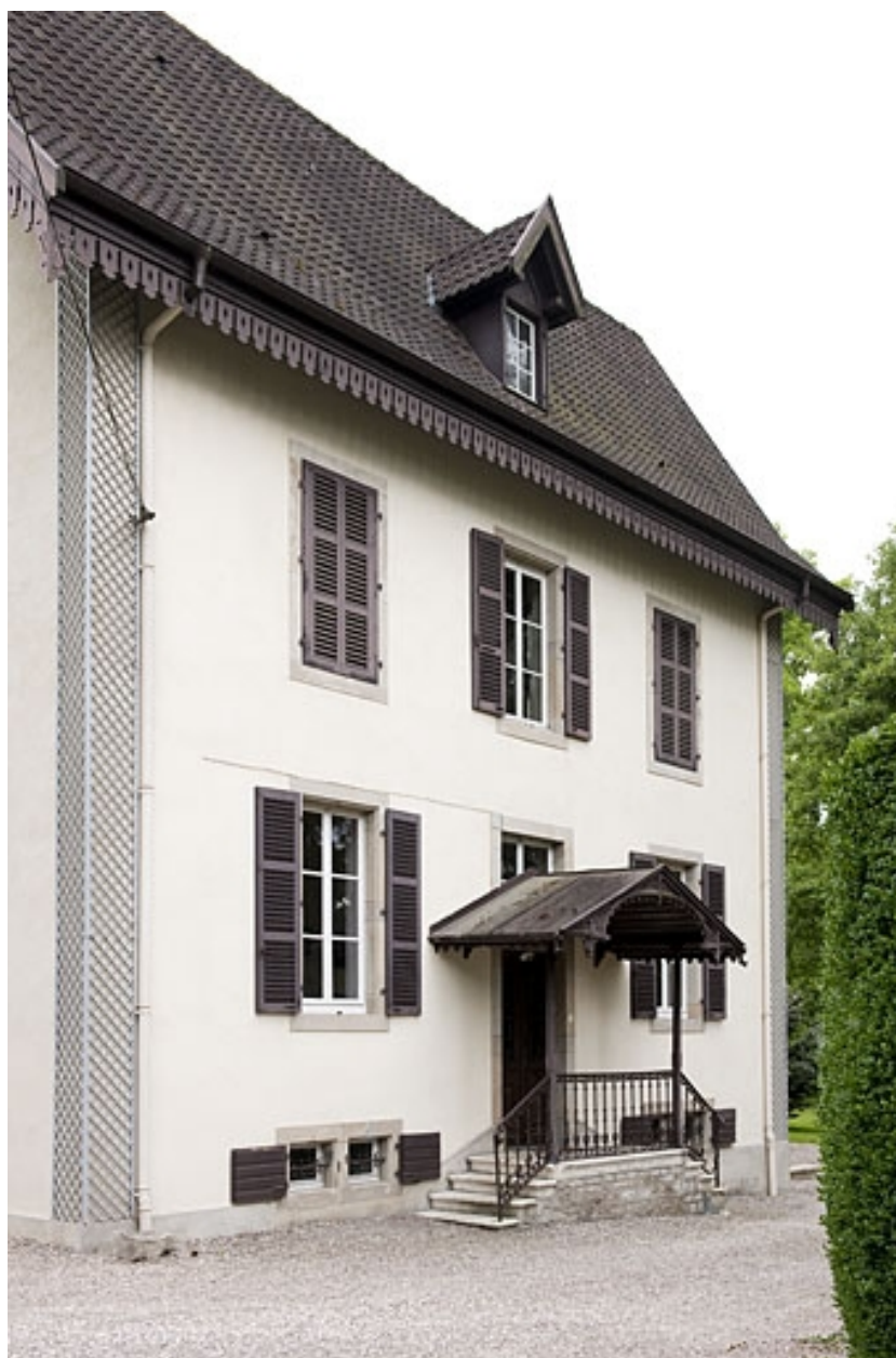
Façade nord vue de trois quarts.
