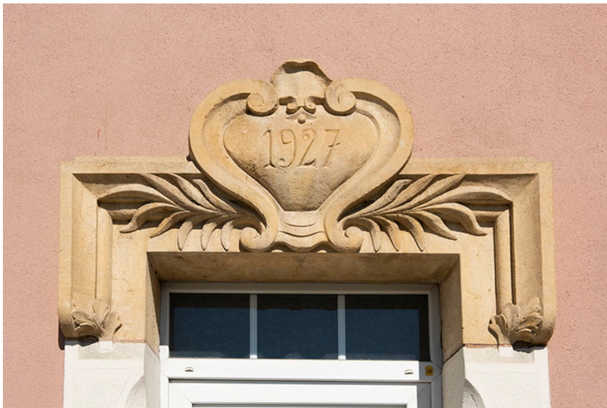
Façade antérieure : linteau daté 1927.
