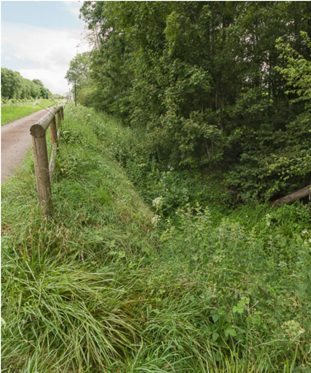
Vue de l'aqueduc.
