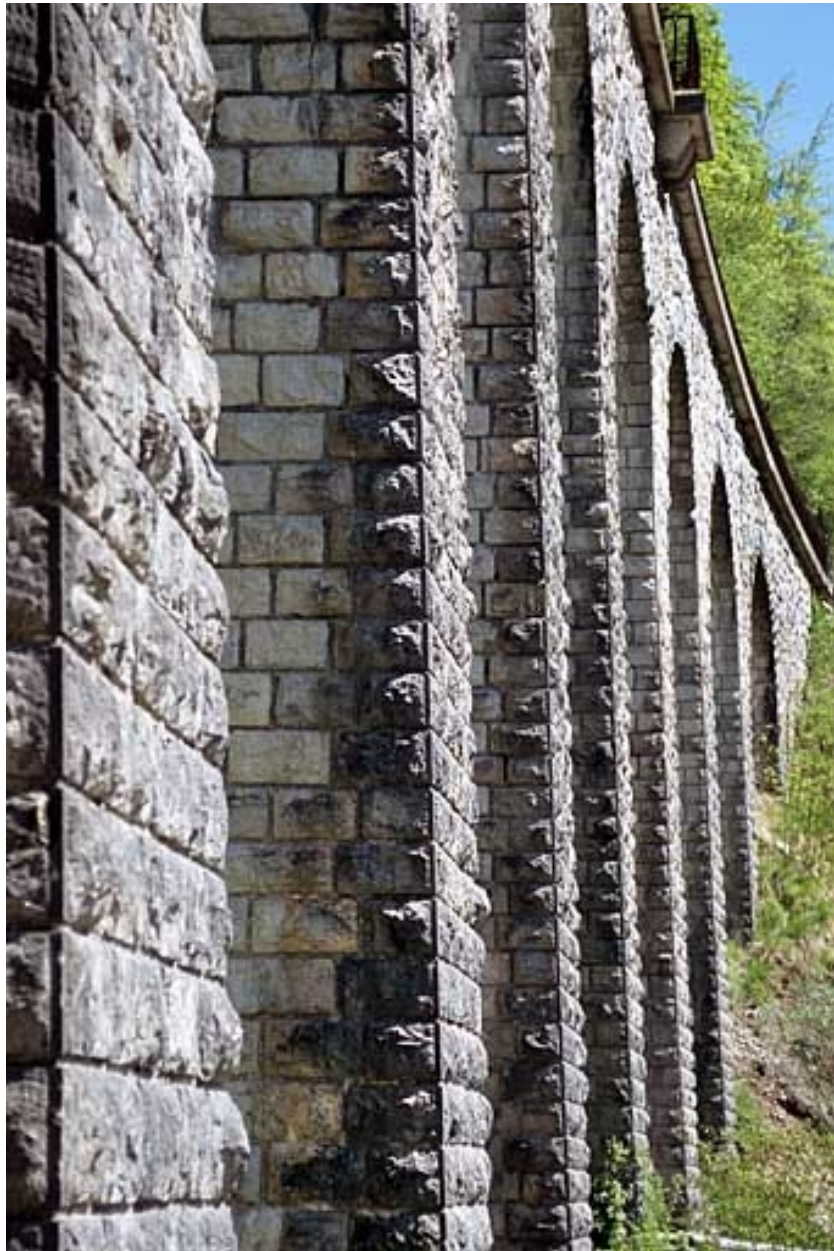
Viaduc du Puits : piles vues en enfilade.
