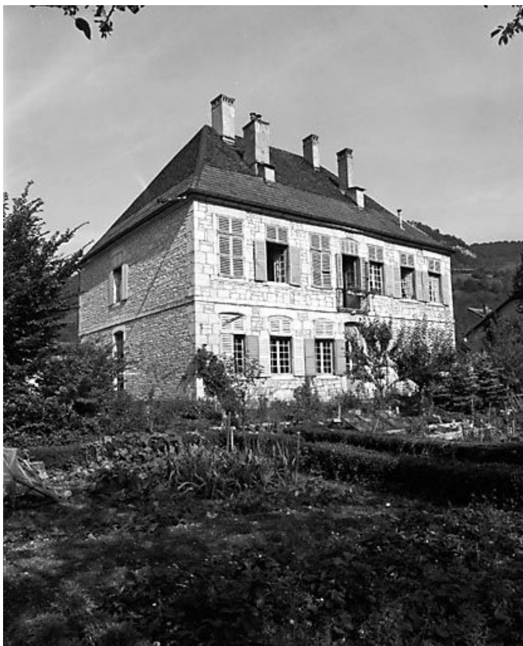
Façade postérieure et face latérale gauche.
