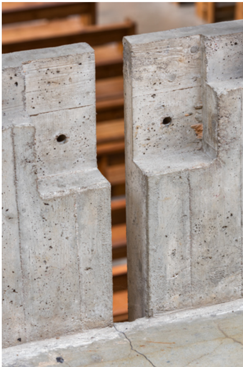
Garde-corps de la tribune sud. Détail de trois-quarts.
