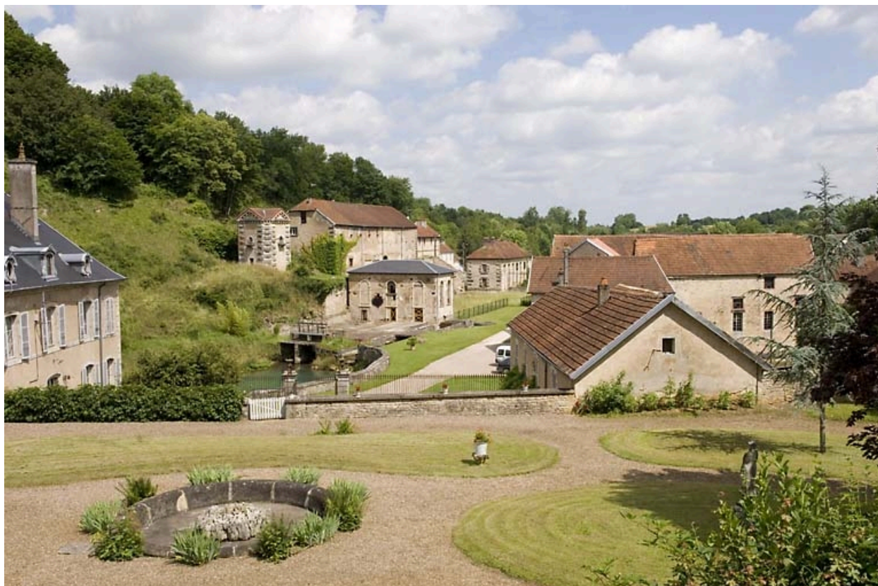
Vue d'ensemble depuis le parc du logement patronal, à l'est.
