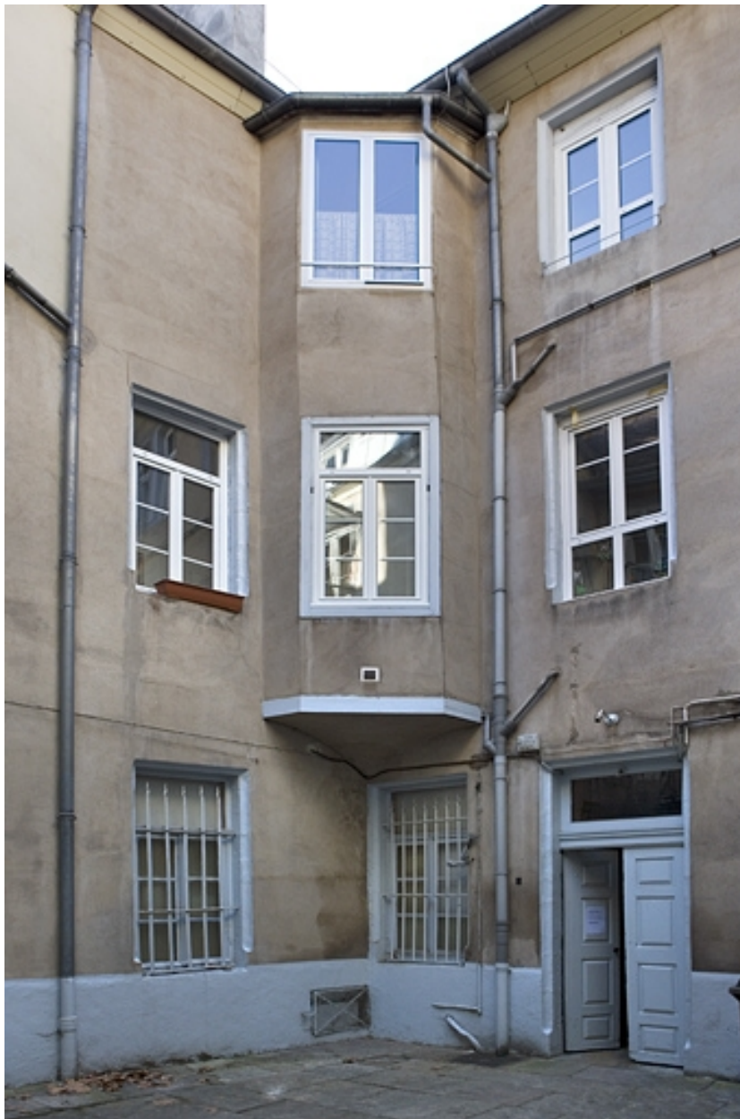
Détail des façades depuis le fond de la première cour.
