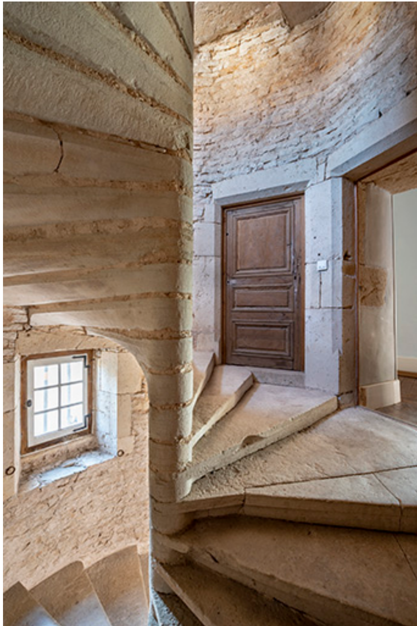
Escalier en vis, premier étage.
