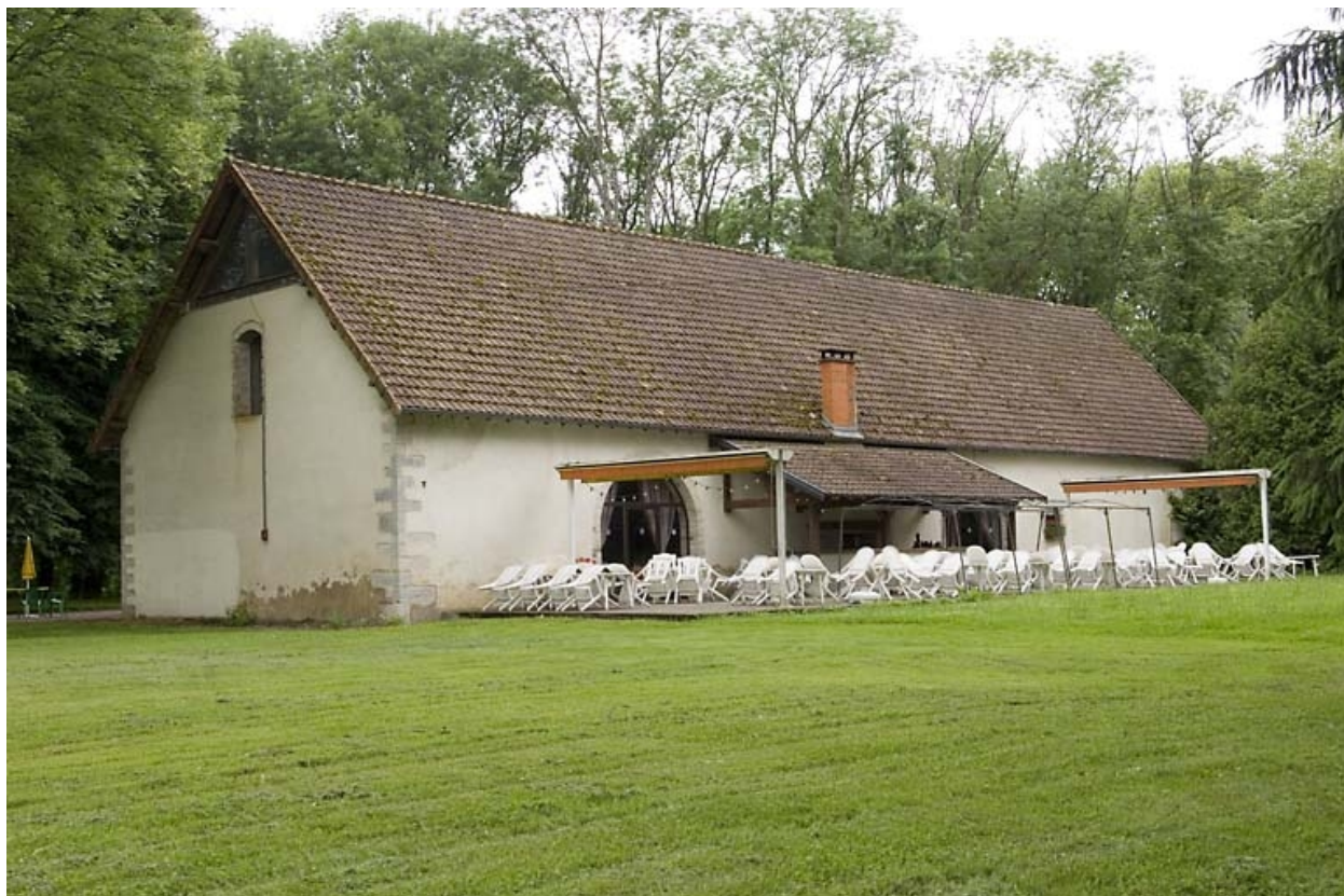
Ancienne halle à charbon depuis le sud.
