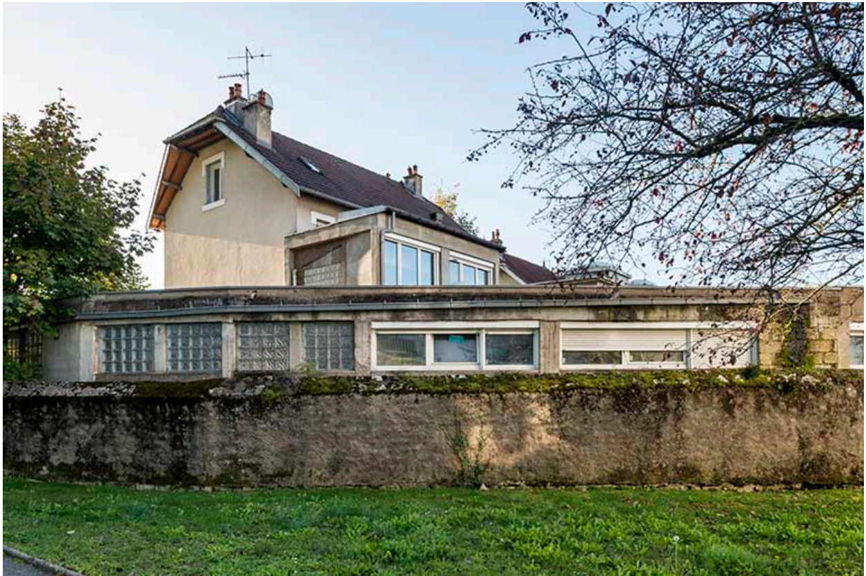
Atelier de fabrication depuis le nord.
