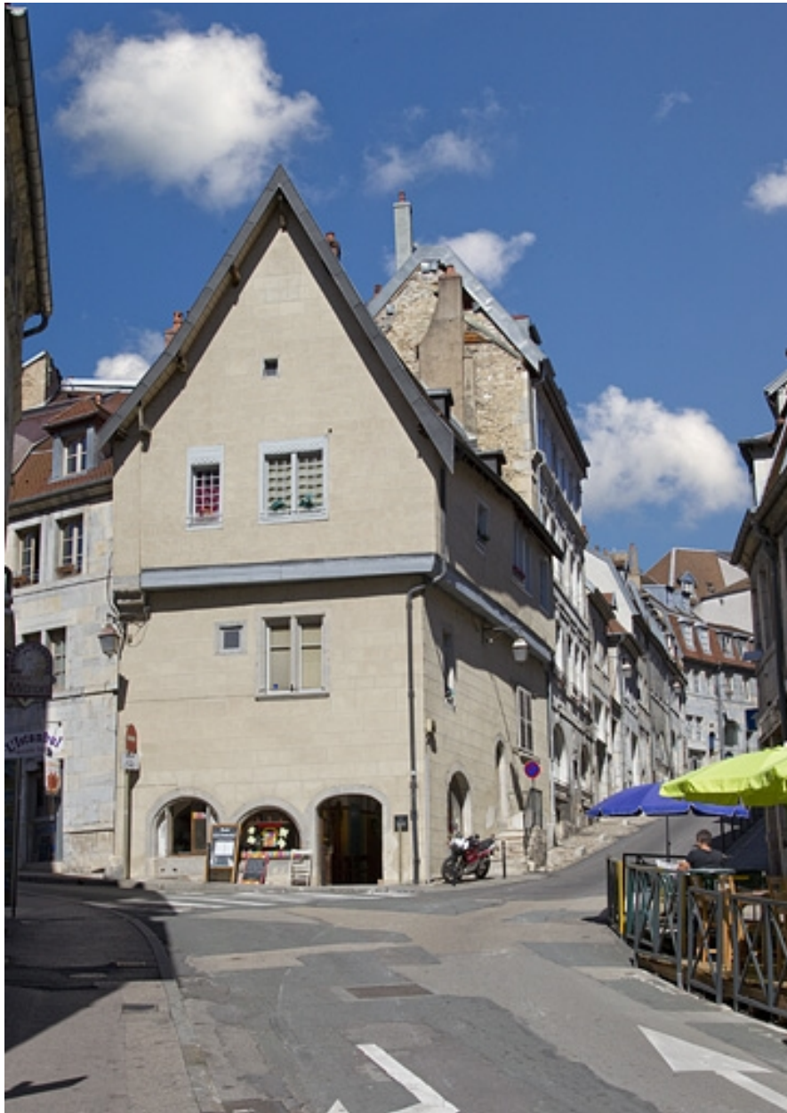
Maison : vue d'ensemble.
