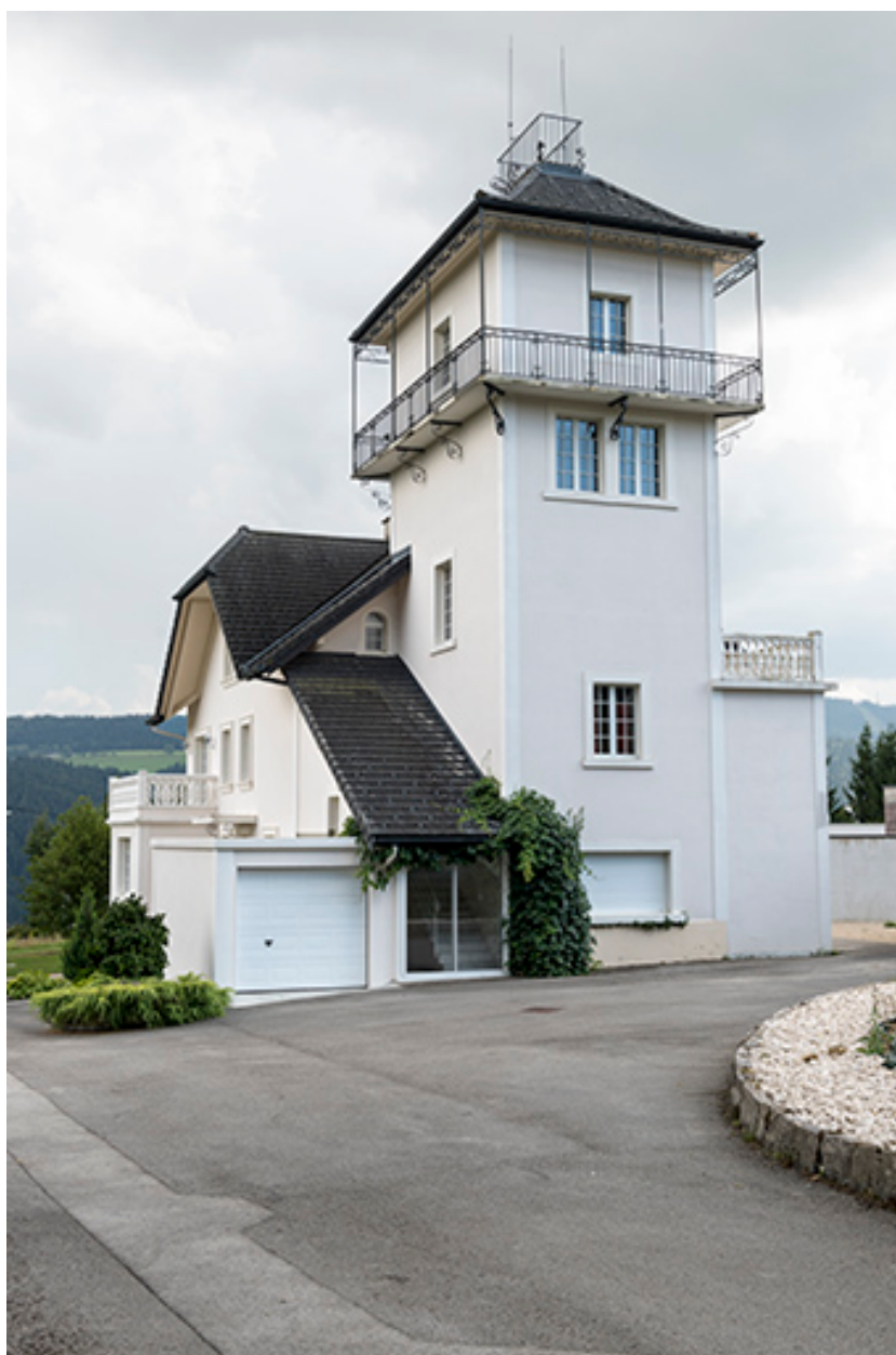
Façade latérale droite.
