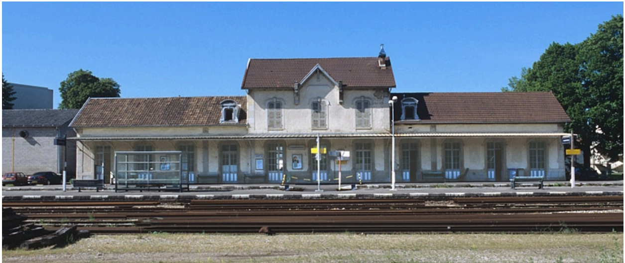
Bâtiment des voyageurs : façade postérieure.
