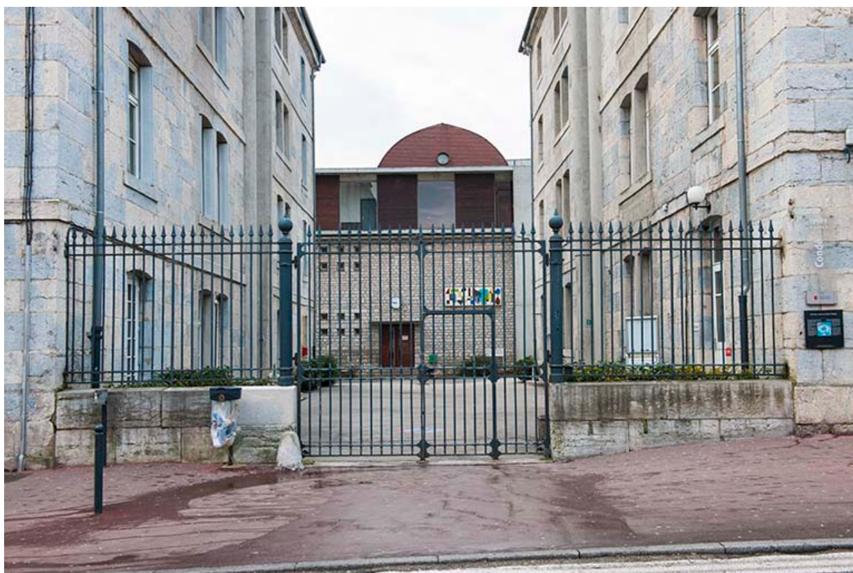
Grille d'entrée donnant sur la place.
