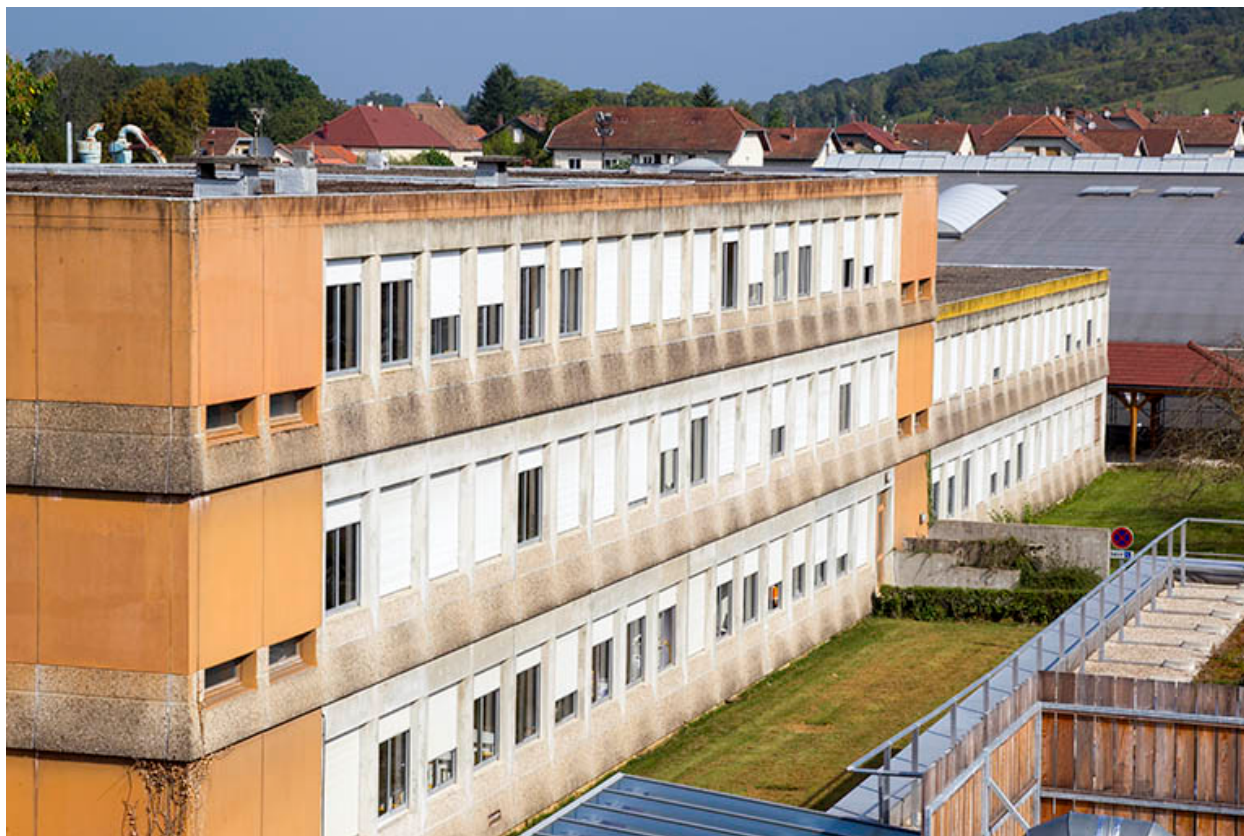
Externat : façade est.
