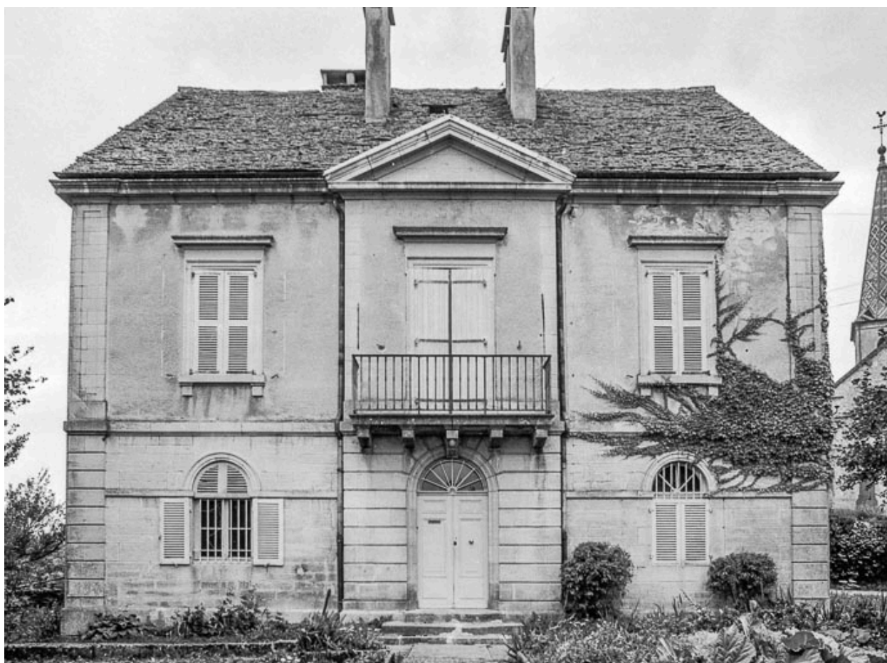
Façade antérieure vue rapprochée de face.
