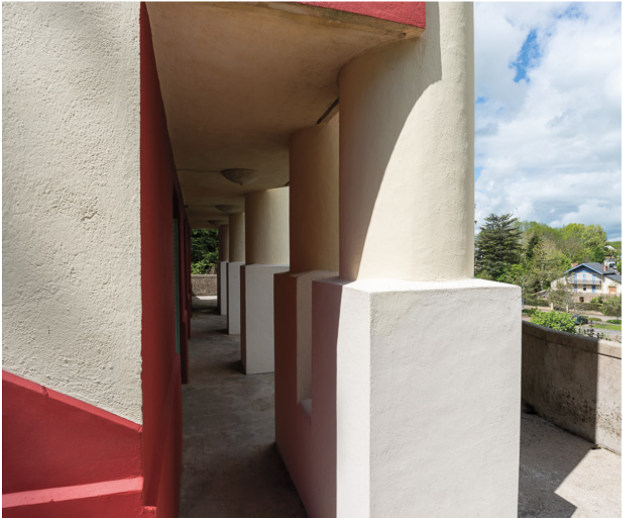
Terrasse de la façade nord, socle des colonnes.
