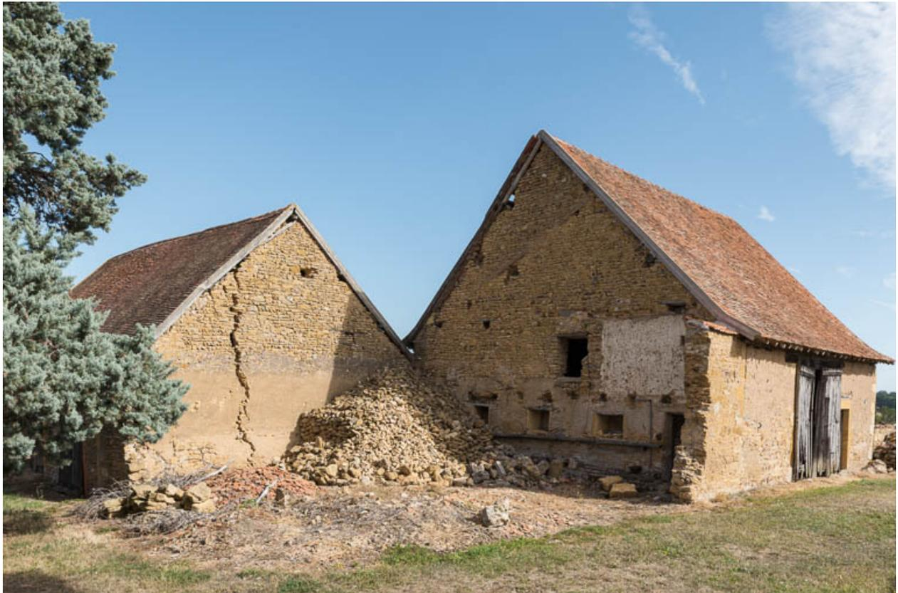
Vue des deux ailes de dépendances. A la jonction des deux bâtiments, une ancienne étable à bovins a été démolie suite à l'effondrement de sa charpente..
